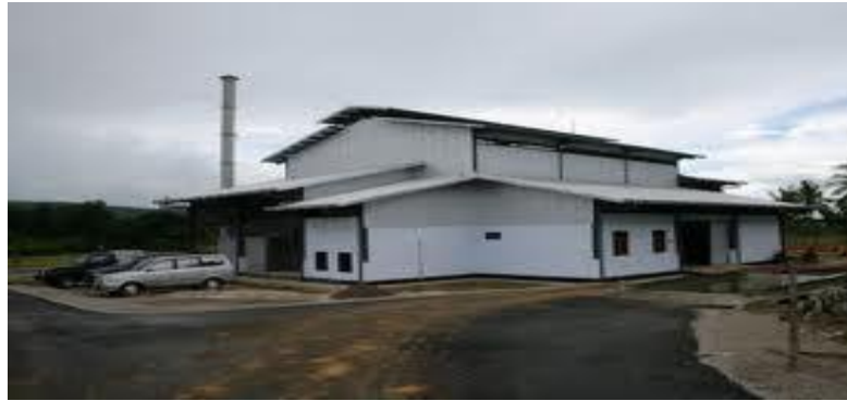
Gudang penyimpanan pakan tampak dari luar
